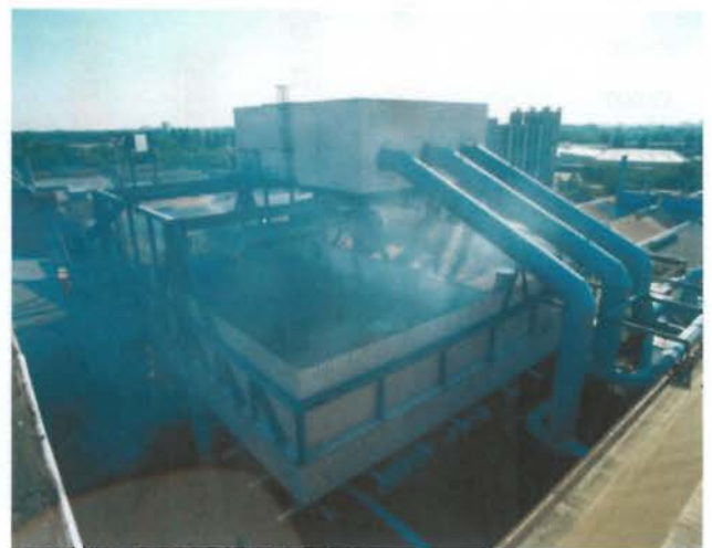
Biofilter Ost: Teilstränge führen zu den Luftbefeuchtern
